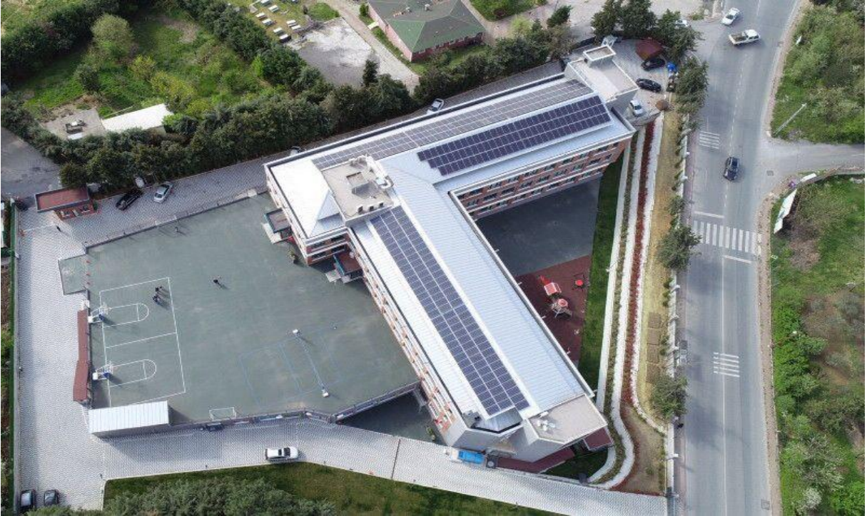
Şekil 9. İleri Nesil Okulları Çatı Güneş Enerjisi Paneli Uygulaması
